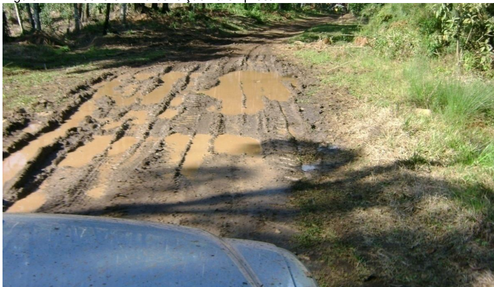
Figura 11 – Trecho em má condição na empresa B.
