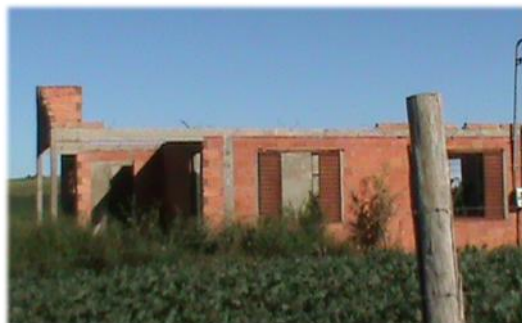
Figura 08 18 : Casa inacabada no Reassentamento. Fonte: EHRHARDT, C.M.A.M, 2012.
