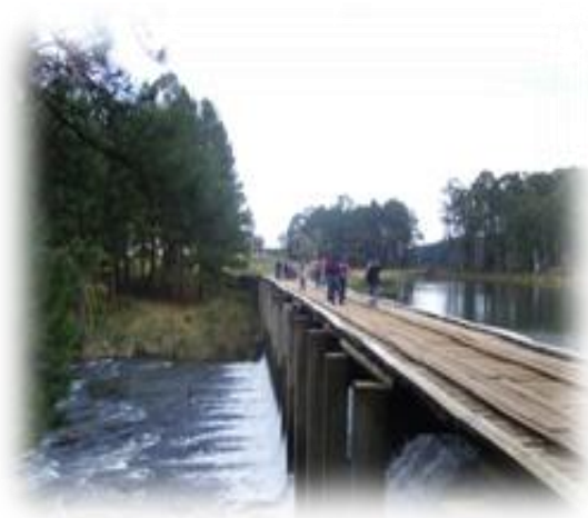
Figura 04: Barragem na Comunidade Barragem Still.
