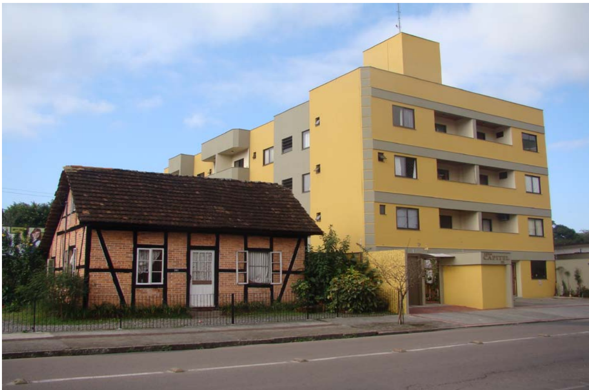
Figura 7: Casa construída em técnica enxaimel, localizada na zona urbana de Joinville. Fonte: Arquivo da pesquisadora. Gisele Schwede, 25/07/2010.
