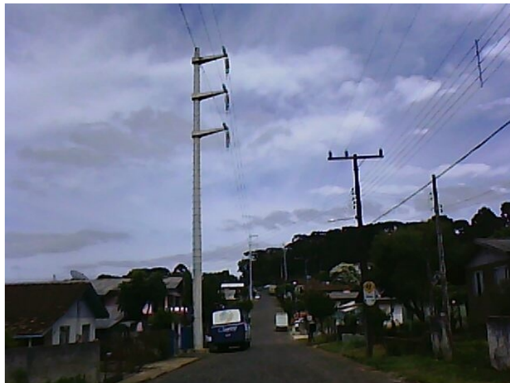
Figura 13: Construções na faixa de servidão da LT 138 kV
