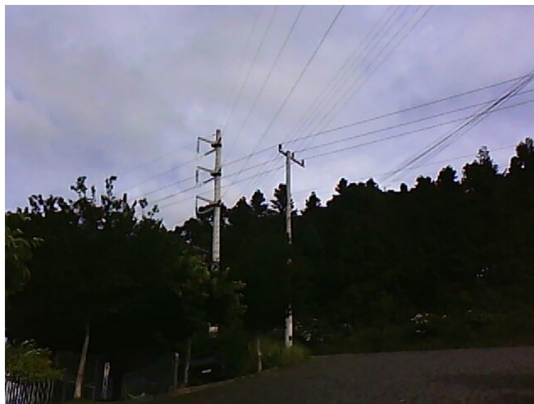
Figura 15: Faixa de servidão da LT 138 kV sem ocupação. Fonte: Própria
