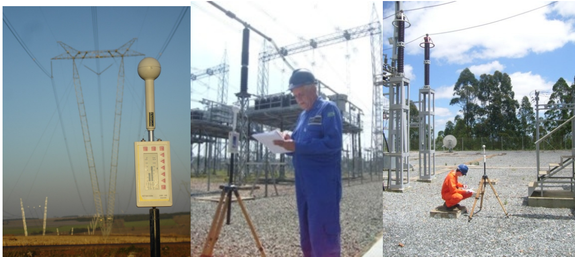
Figura 6: Medições em linha de transmissão de 525 kV, banco de capacitores de 525 kV e subestação de distribuição em 138 kV.
