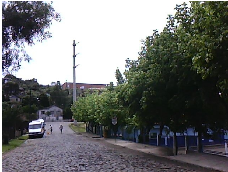
Figura 14: LT 138 kV Esquina Escola Municipal Ensino Básico Vereda dos Trevos Fonte: Própria
