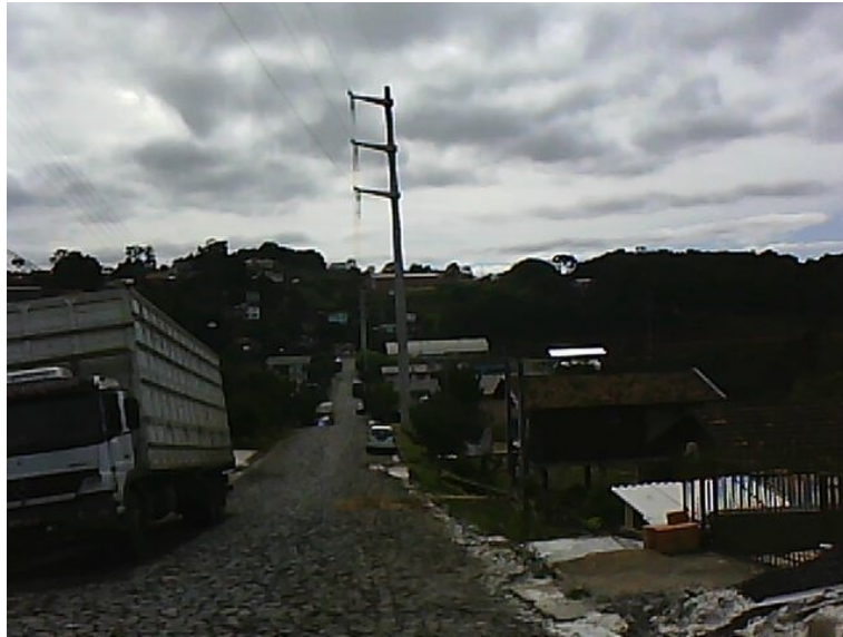
Figura 16: Construção próxima a LT 138 kV.
