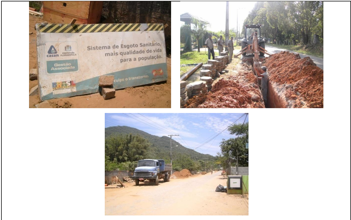
Figura 1: Construção de Sistema de Esgoto Sanitário no Distrito Ribeirão da Ilha
