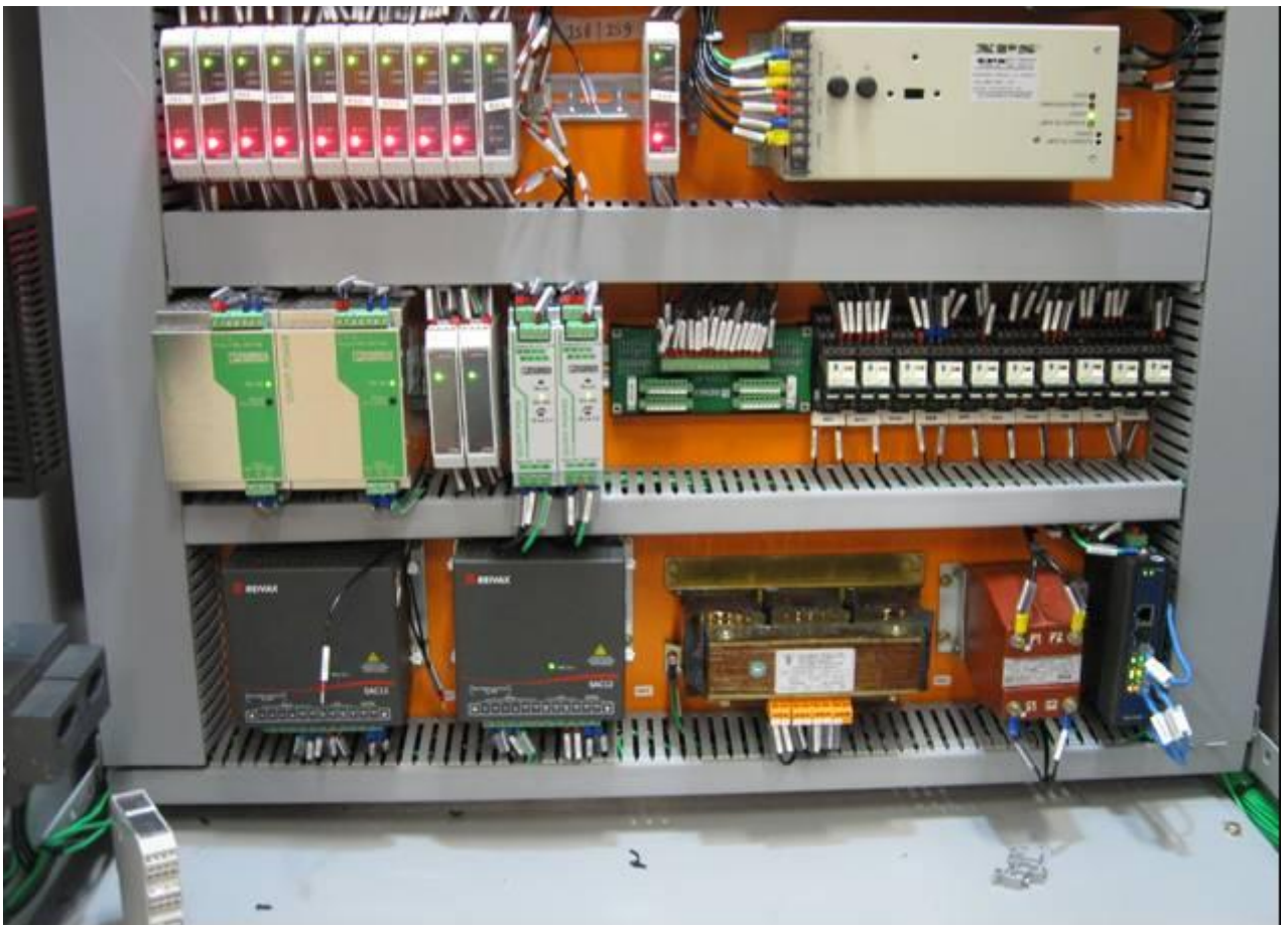
Figura 1 - Detalhe do painel de controle, mostrando os amplificadores isolados
