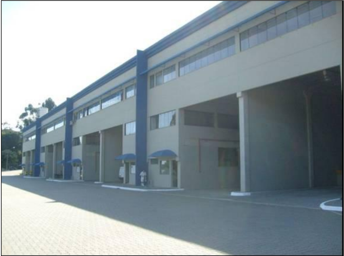
Figura 5 - Vista Externa da GCE2
