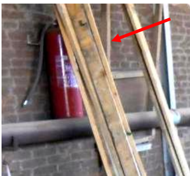
Fotografia 13: Extintor obstruído
