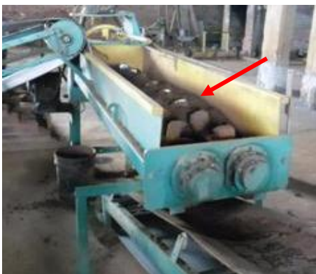
Fotografia 7: Partes móveis sem proteção
