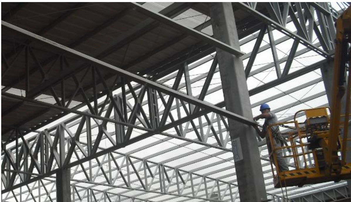
Figura 41 – Terça de fechamento sendo parafusada
