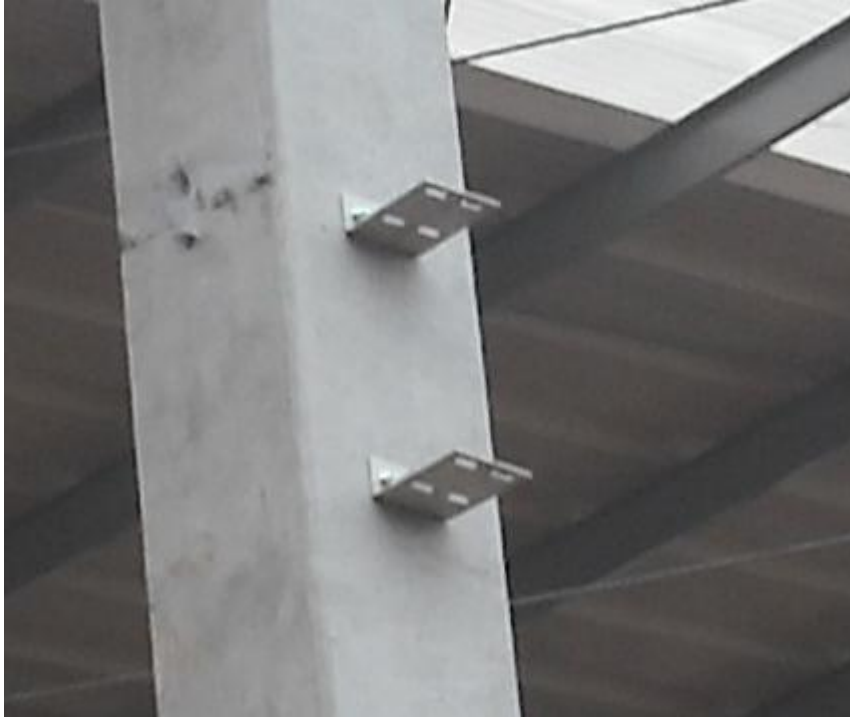
Figura 40 – Encosto de fechamento fixado no pilar de concreto
