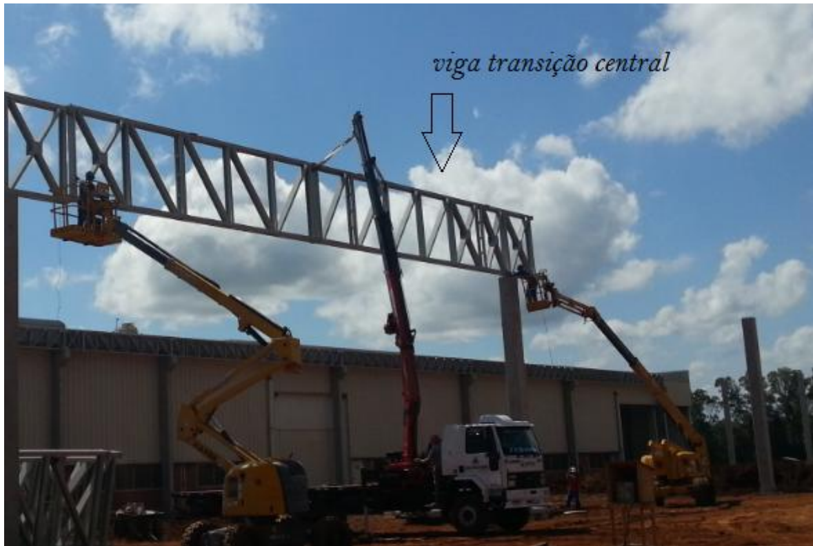
Figura 15 – Viga de transição central sendo montada
