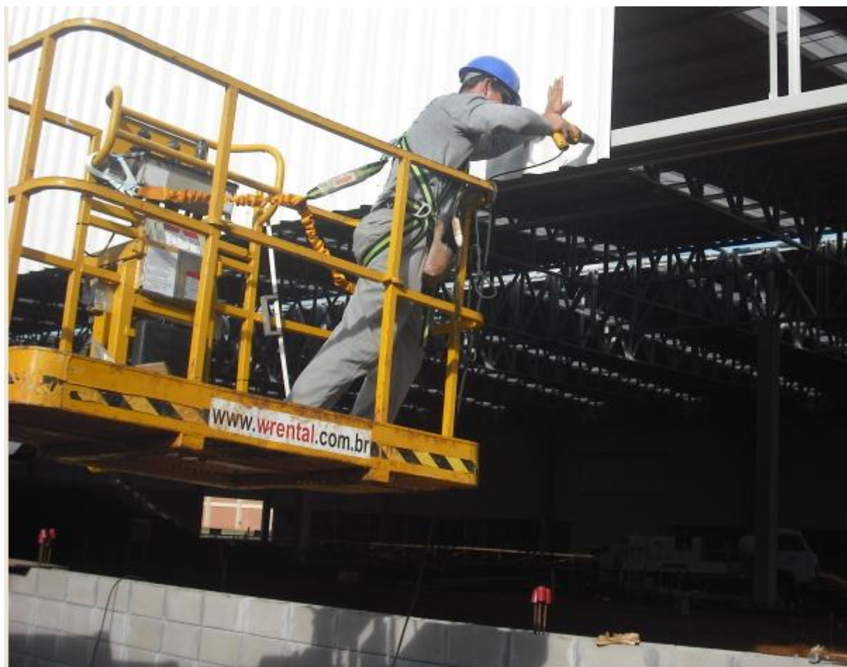
Figura 52 – Funcionário colocando o parafuso autobrocante de fixação da telha de fechamento
