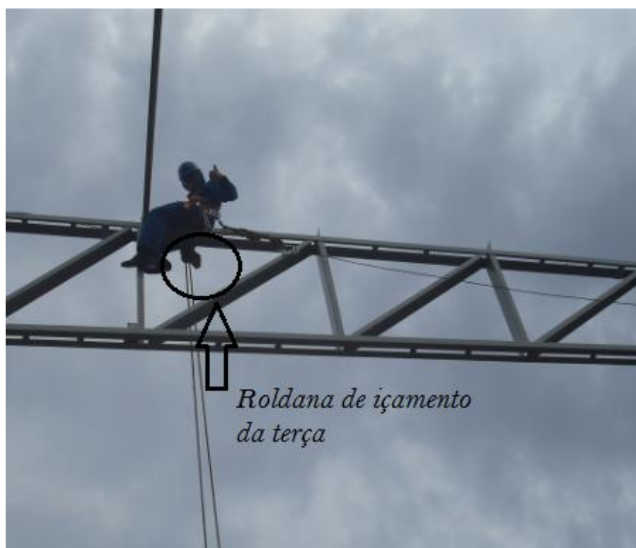
Figura 32 – Posição do funcionário para fixação das terças de cobertura
