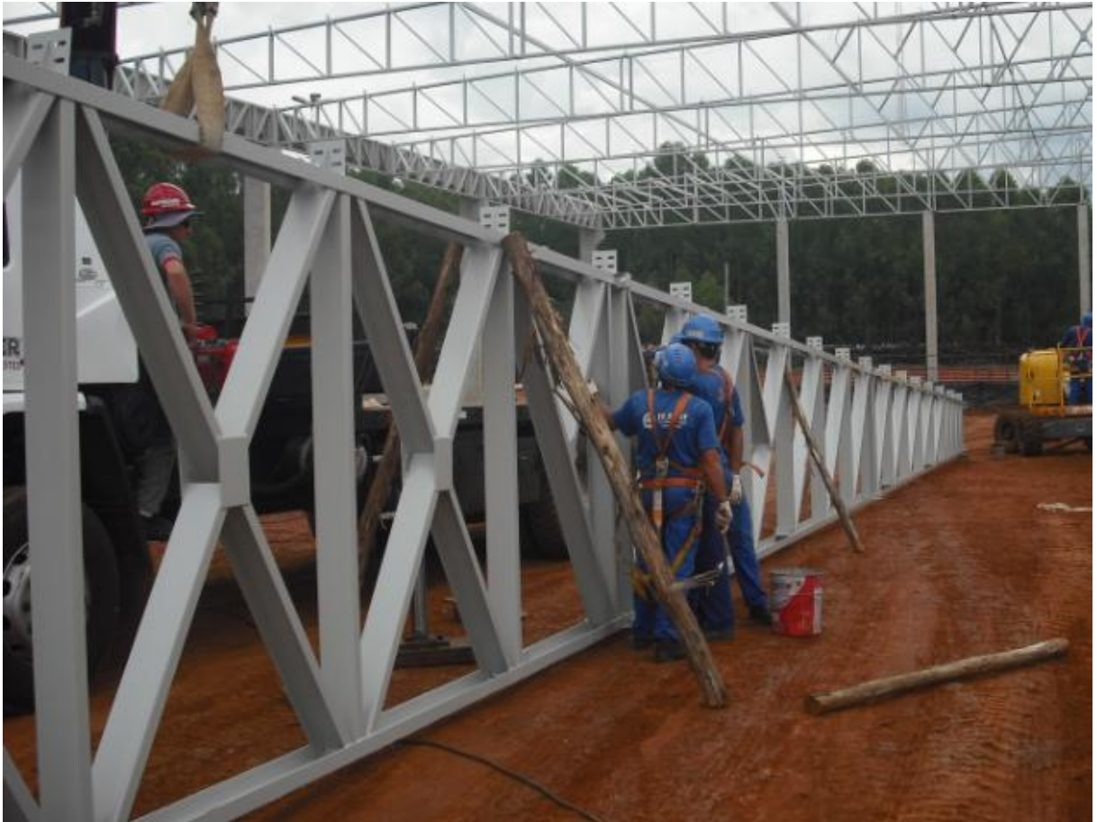
Figura 25 – Montagem das peças metálicas no solo
