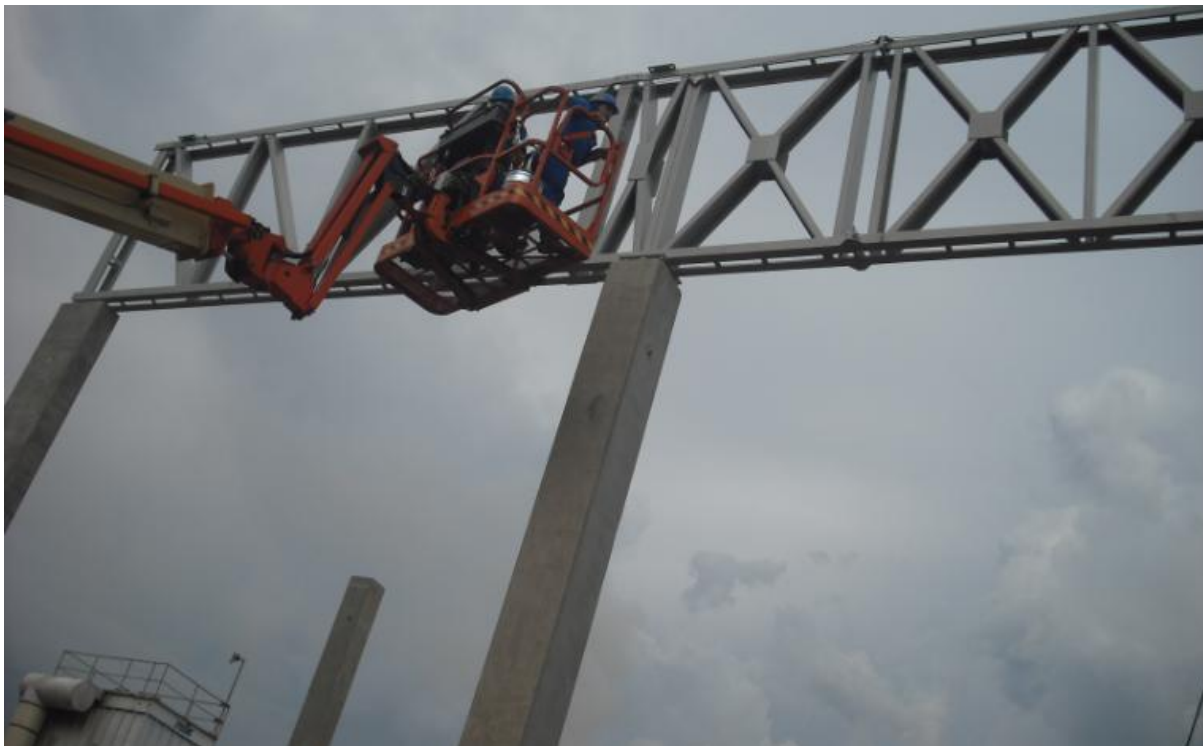
Figura 29 – Parafusamento da viga de transição nos chumbadores inseridos
