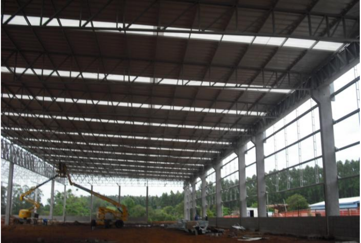
Figura 23 – primeira etapa da obra com telha de cobertura
