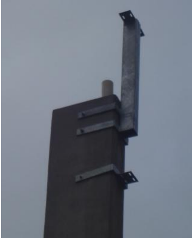
Figura 38 – Pilarete de fechamento montado
