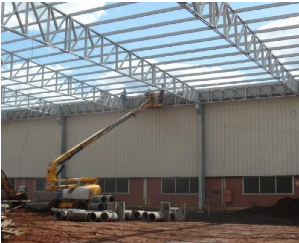
Figura 35 – Funcionários fazendo a fixação das correntes de cobertura
