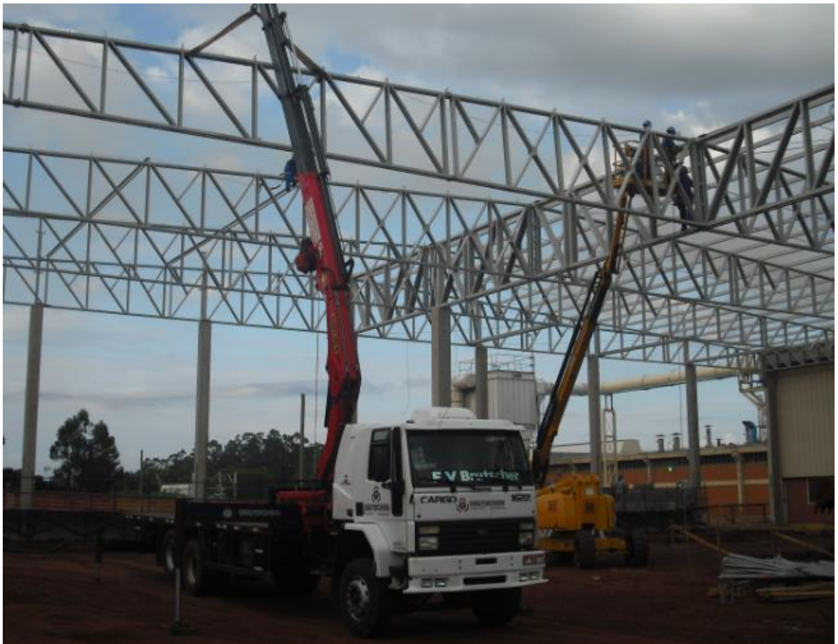
Figura 31 – Içamento e parafusamento das tesouras de cobertura.
