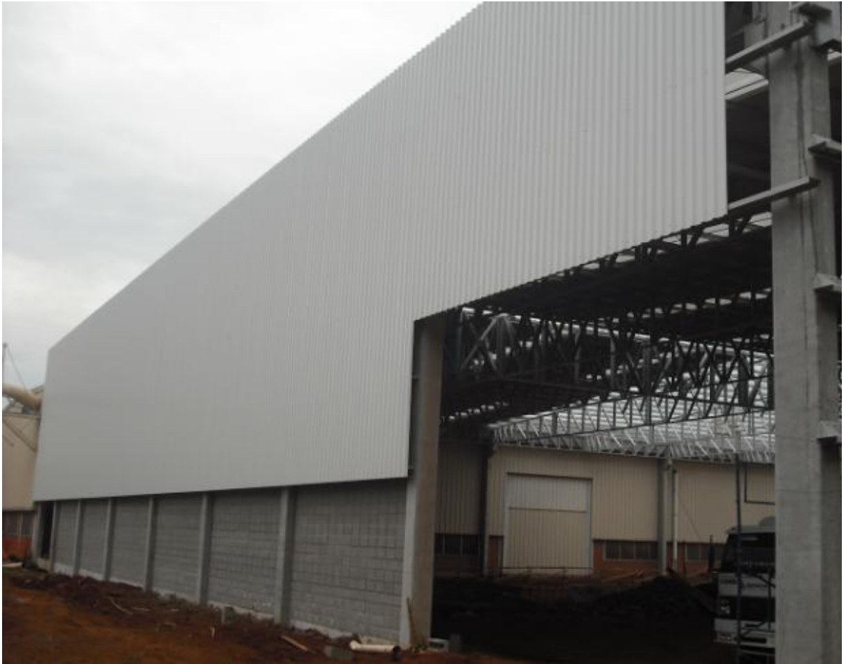
Figura 24 – oitão com telhas de fechamento
