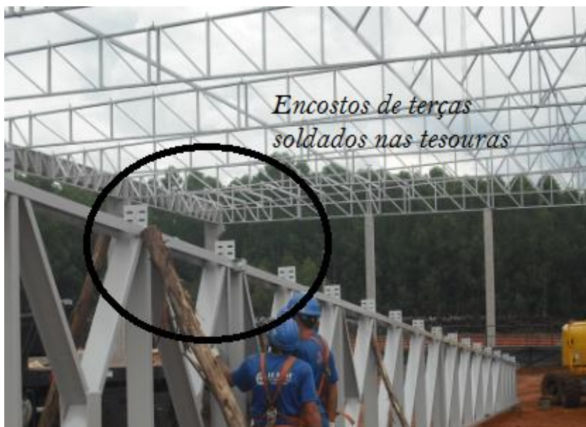
Figura 18 – Detalhe encosto de terça soldado na tesoura
