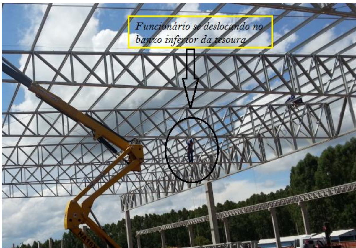
Figura 36 – Funcionário se deslocando para fixação de vigas e tirantes de travamento
