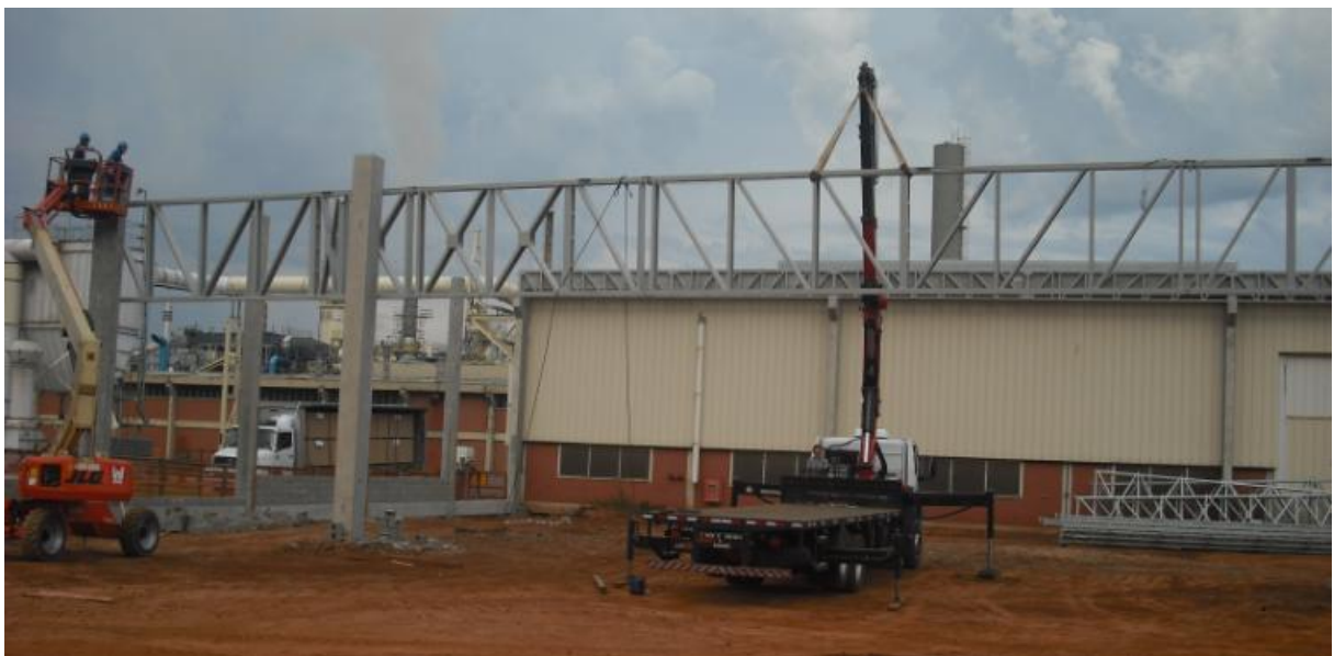
Figura 28 – Içamento do primeiro vão da viga central
