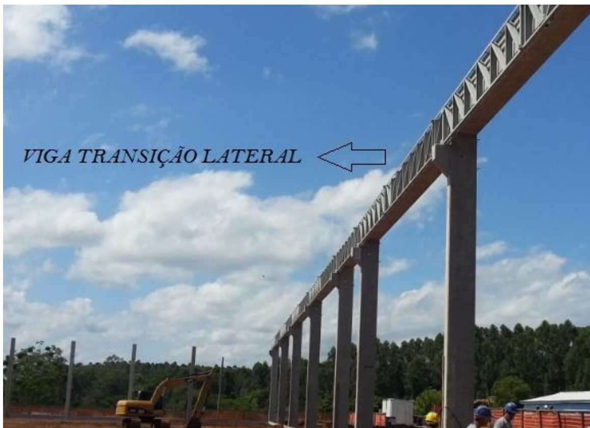
Figura 14 – Viga de transição lateral montada
