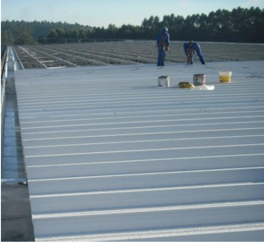
Figura 44 - Funcionários fazendo a montagem das telhas de cobertura
