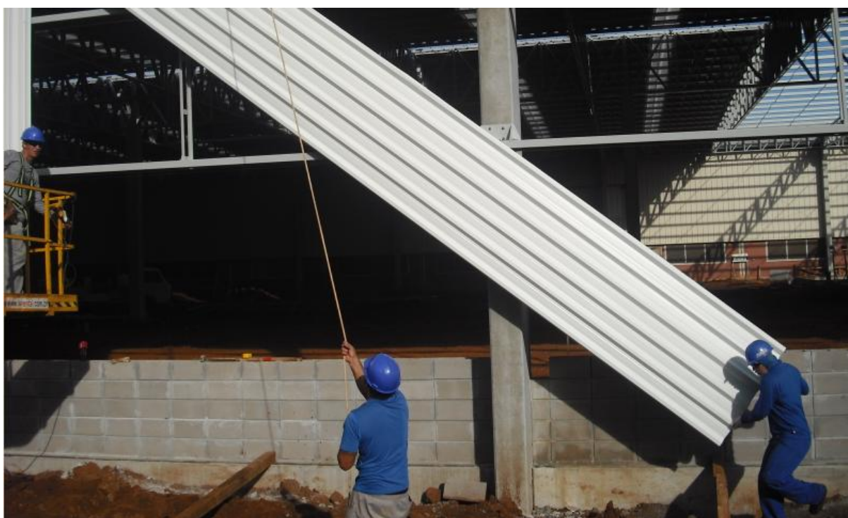
Figura 51 – Funcionários fazendo o içamento da telha de fechamento
