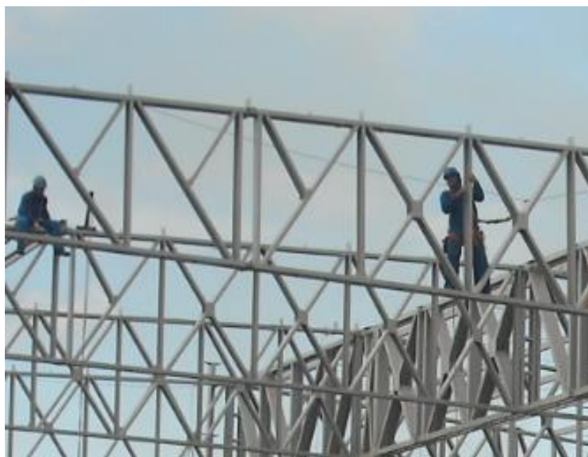
Figura 37 – Funcionários fazendo o parafusamento do contravento superior
