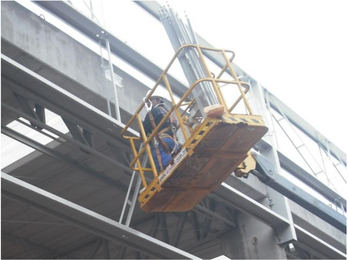
Figura 43 - Funcionário fazendo a montagem das correntes de fechamento
