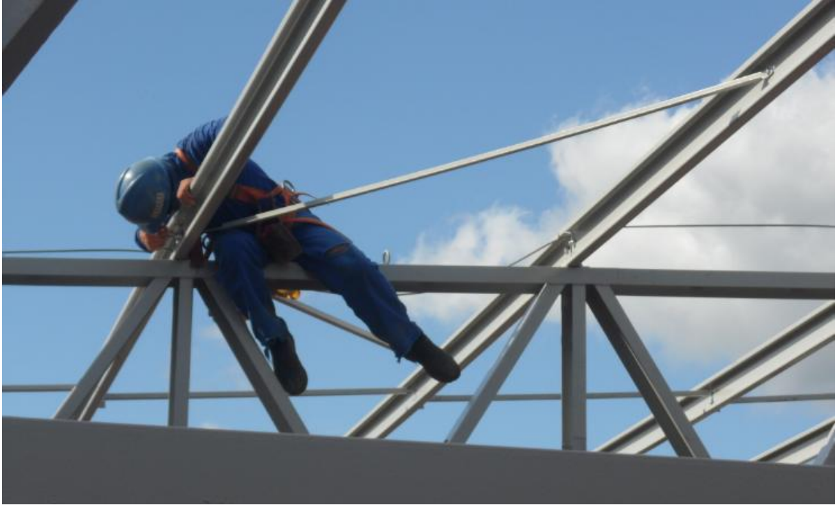
Figura 34 – Funcionário fazendo a fixação da diagonal na tesoura
