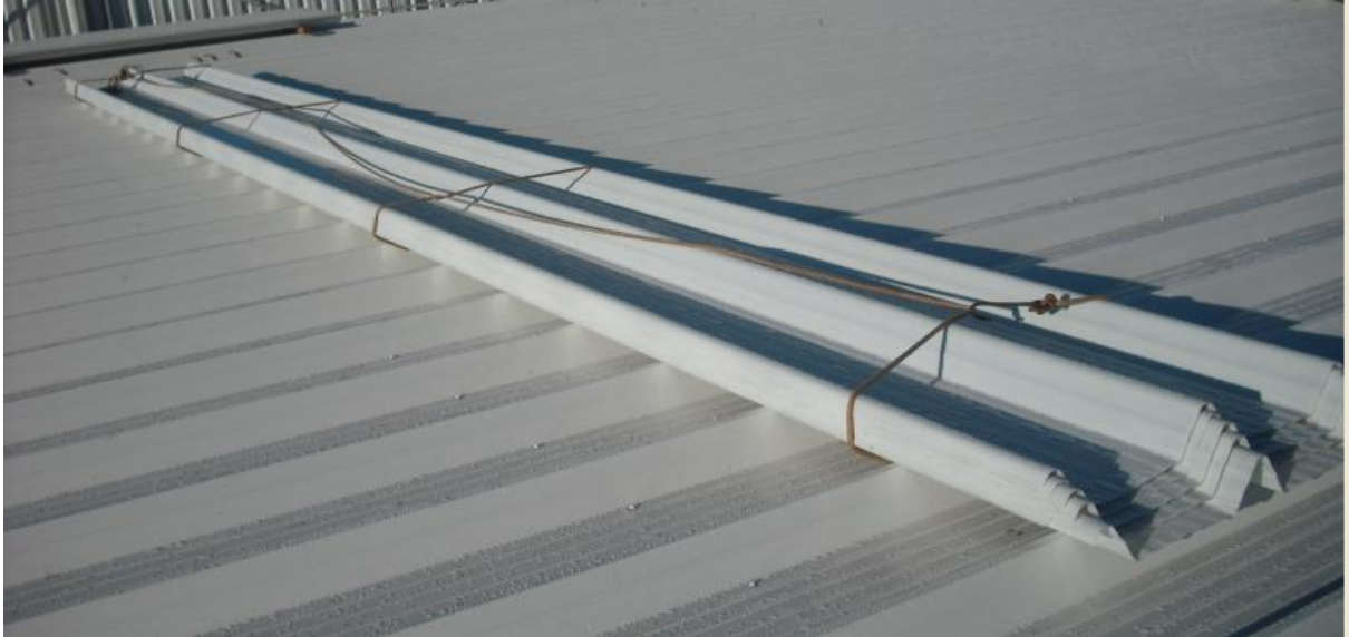
Figura 45 - Pacote de telhas sobre cobertura já montada
