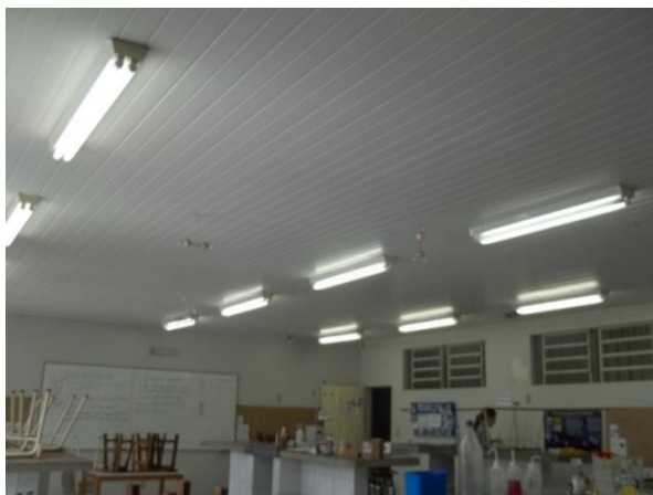
Fotografia 4: Teto de PVC (policloreto de vinila). Fonte: E. E. B. Presidente Artur da Costa e Silva (2013)
