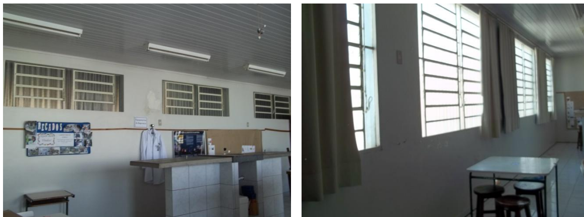
Fotografia 6: Janelas localizadas acima da altura das bancadas (lado esquerdo) e abaixo da altura das bancadas (lado direito).
