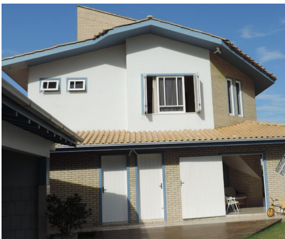
Figura 43 - Janelas da Edificação
