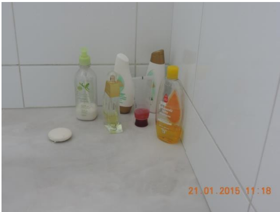
Figura 34 - Produtos de higiene no piso do Box do banheiro
