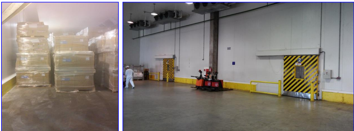
Figura 4 – À direita, detalhe da área interna da câmara de refrigeração, com produtos já estocados. À esquerda, detalhe da pré-câmara, utilizada para movimentação de cargas.
