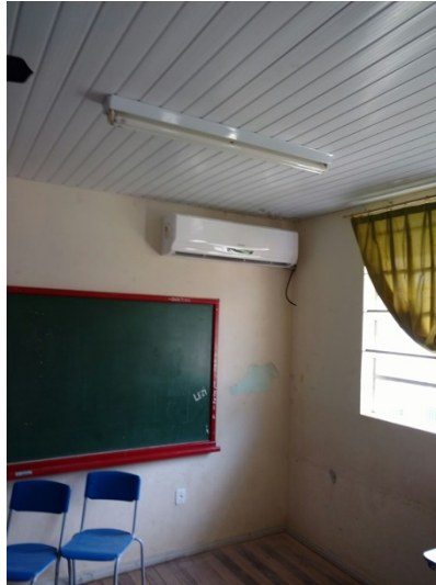
Figura 9 – Instalação de novos aparelhos de Ar Condicionado
