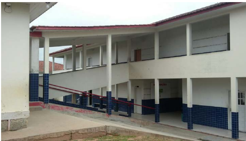
Figura 6 – Rampas de acesso
