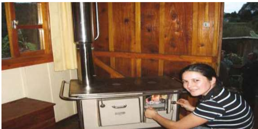
Figura 1 – Equipamento instalado na chaminé do fogão a lenha para aquecimento de água (FREITAS, 2014).
