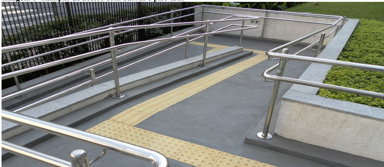
Imagem 1- Rampas de acesso com barras e piso tátil
