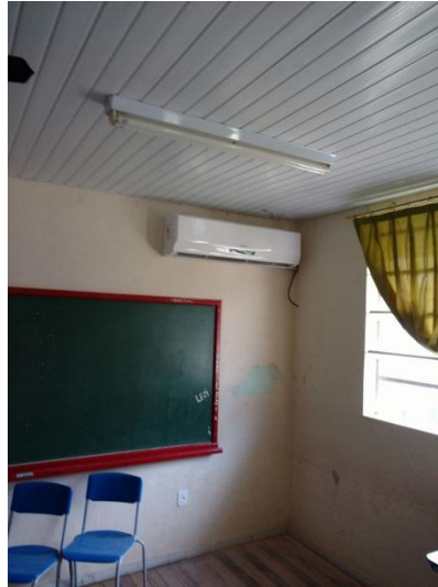
FIGURA 9 – Instalação de novos aparelhos de Ar Condicionado
