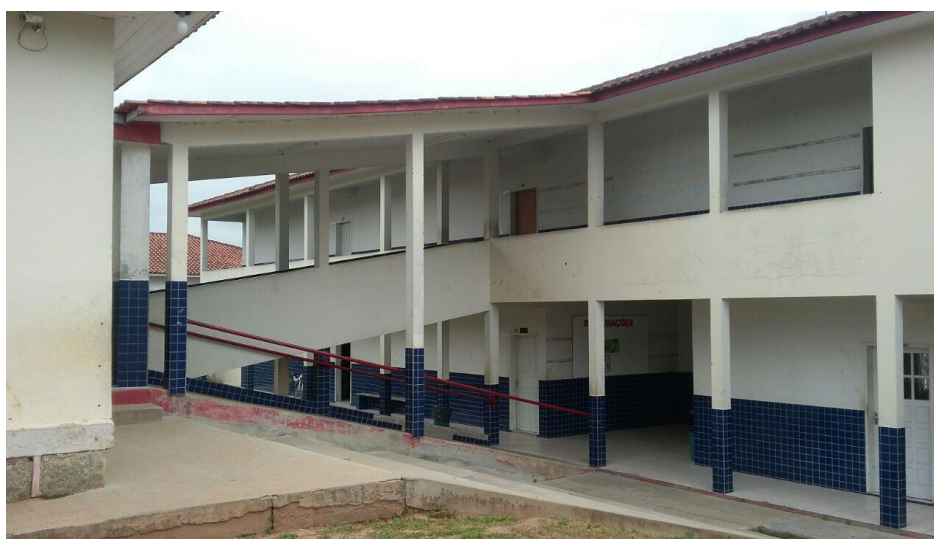
FIGURA 6 – Rampas de acesso
