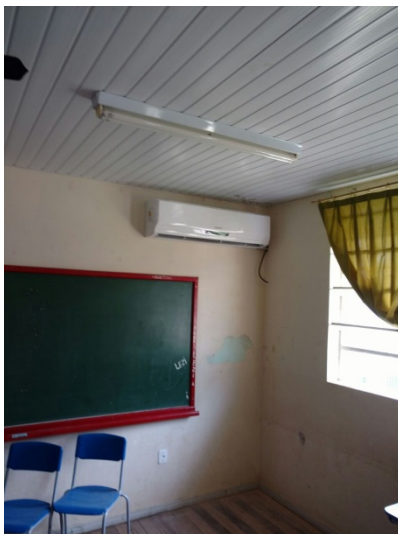
Figura 9 – Instalação de novos aparelhos de Ar Condicionado
