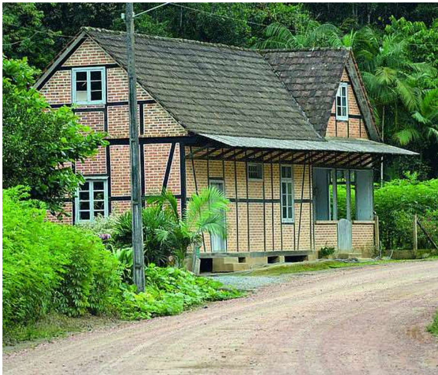
Figura 04: casa da rota enxaimel na cidade de Pomerode/SC
