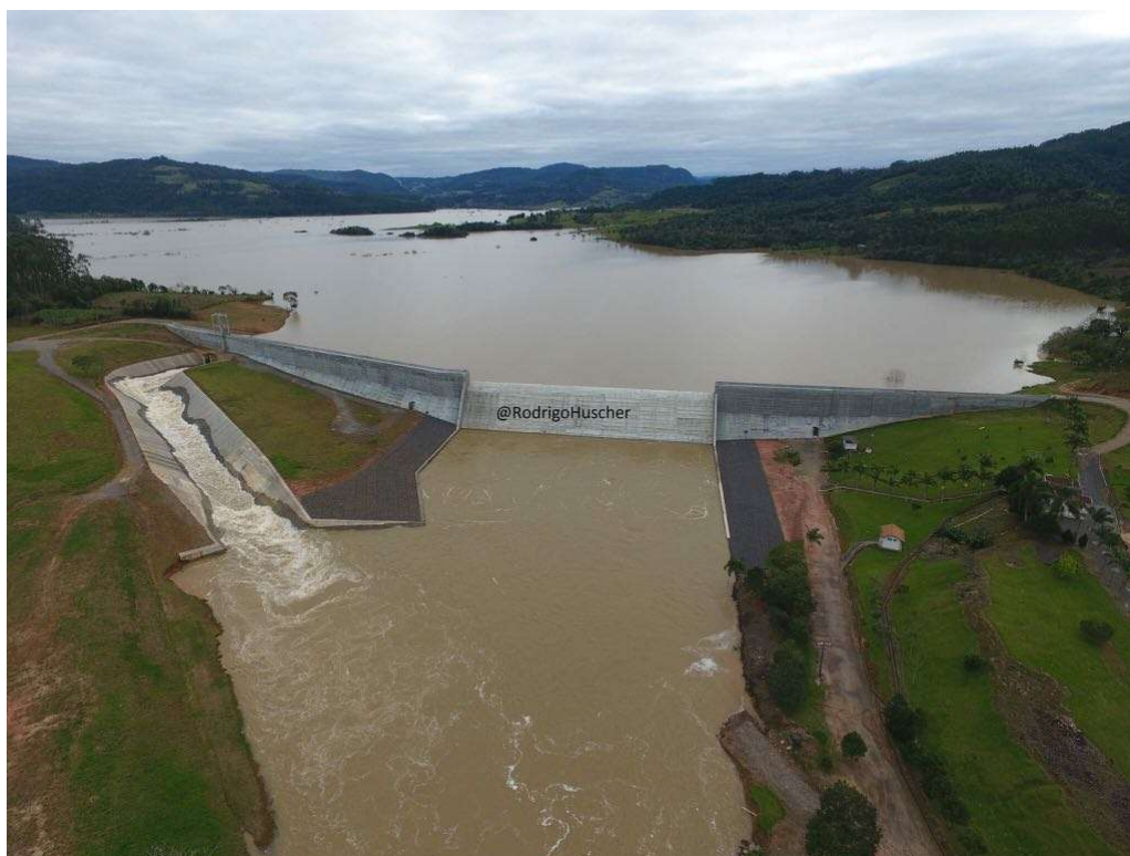
Imagem 2 – Barragem Oeste em Taió com canal extravasor em funcionamento
