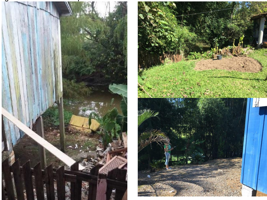
Figura 13: Residências próximas ao rio.
