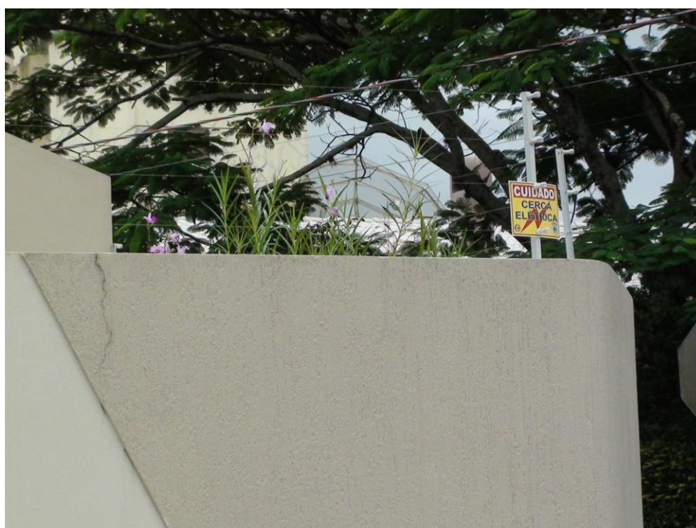
Figura 15 – Muro com cerca elétrica.
