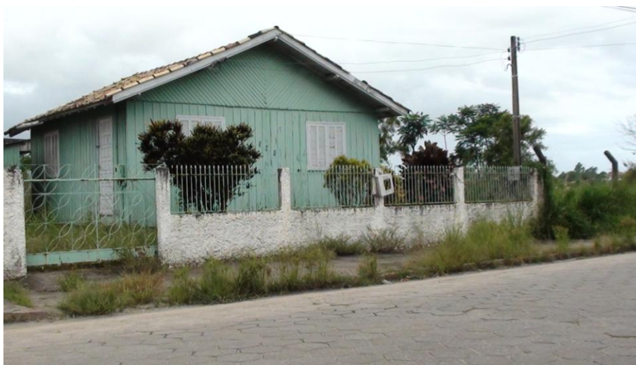
Figura 16 – Residência com descuido na manutenção e limpeza.
