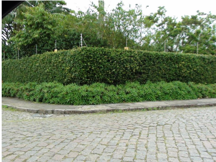
Figura 10 – Muro com problema para a segurança II.
