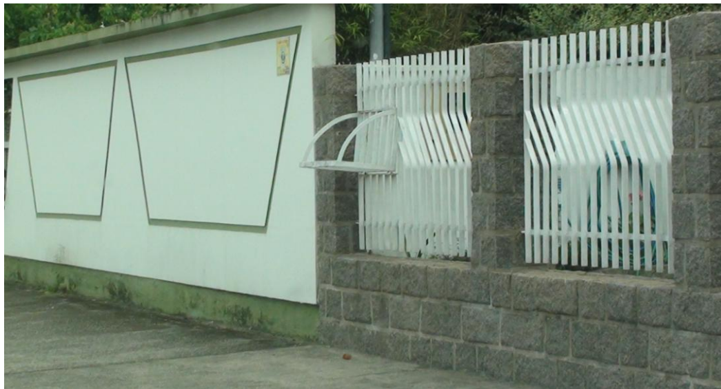
Figura 11 – Suporte de lixo facilitando a transposição do muro I.
