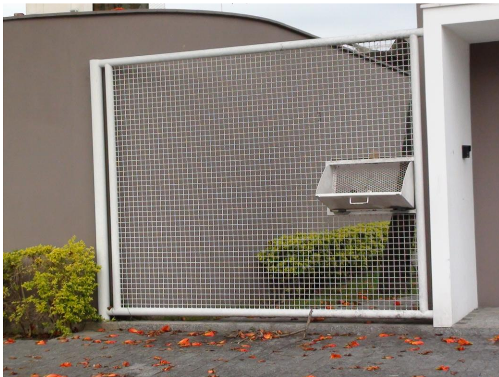
Figura 12 – Suporte de lixo facilitando a transposição do muro II.
