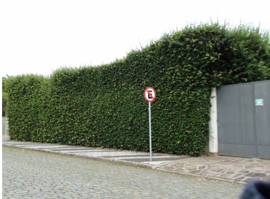
Figura 9 – Muro com problema para a segurança I.
