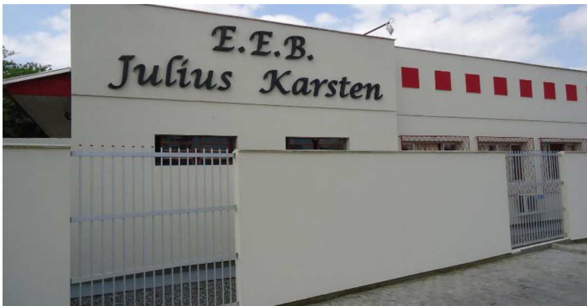
Figura 1 – Fachada frontal da EEB Julius Karsten
