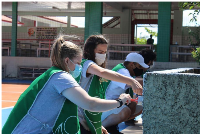
Figura 3 – Realização de melhorias físicas
