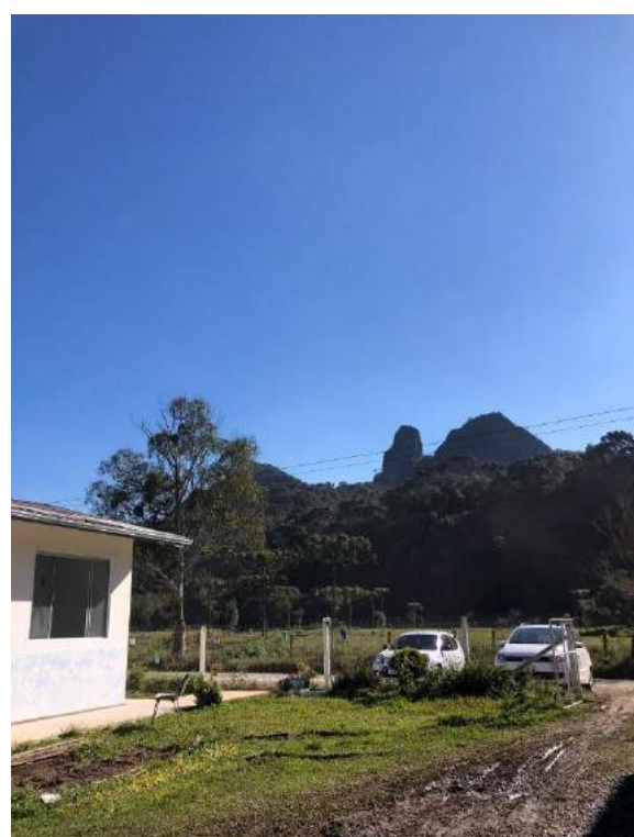
Figura 04 – Vista face frontal – Portão de acesso a veículos
