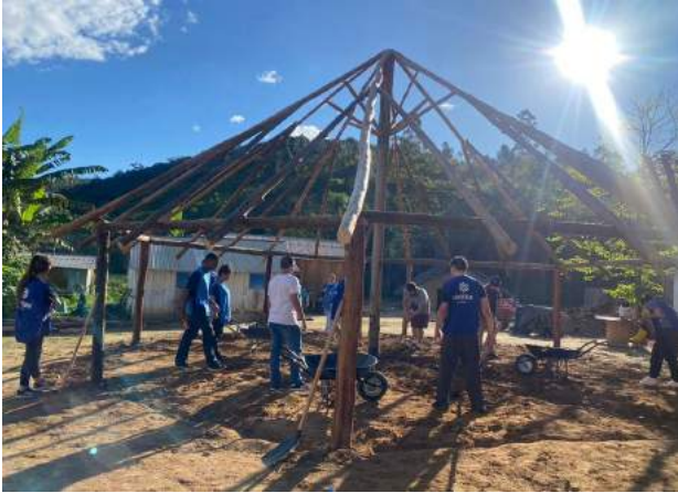
Preparação do terreno casa da cultura
