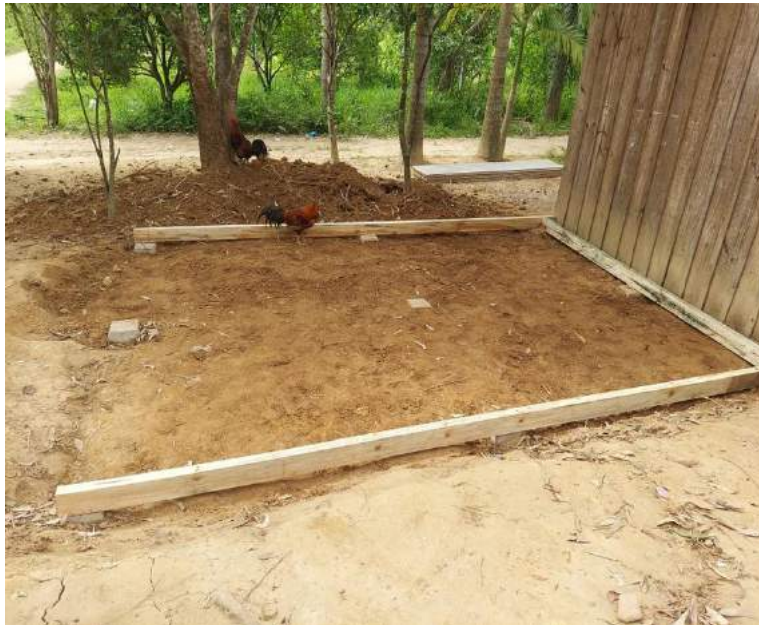
Preparação do terreno e fundação da casa.
