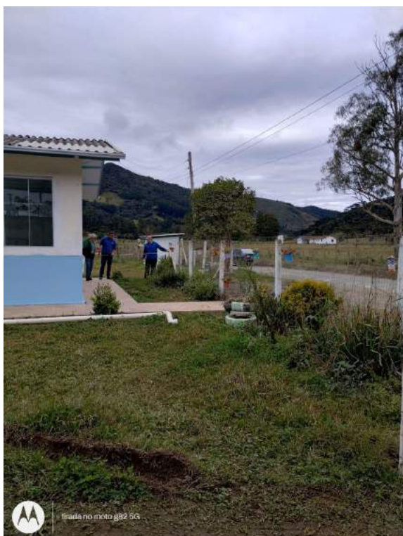
Figura 03 – Vista face frontal – limítrofe com a Estrada
