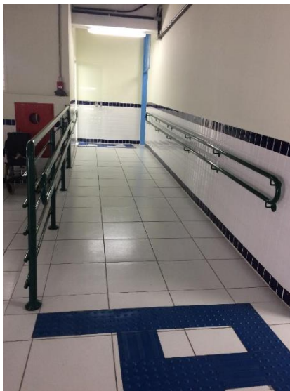
Figura 4 - rampa de acesso a diferentes espaços
