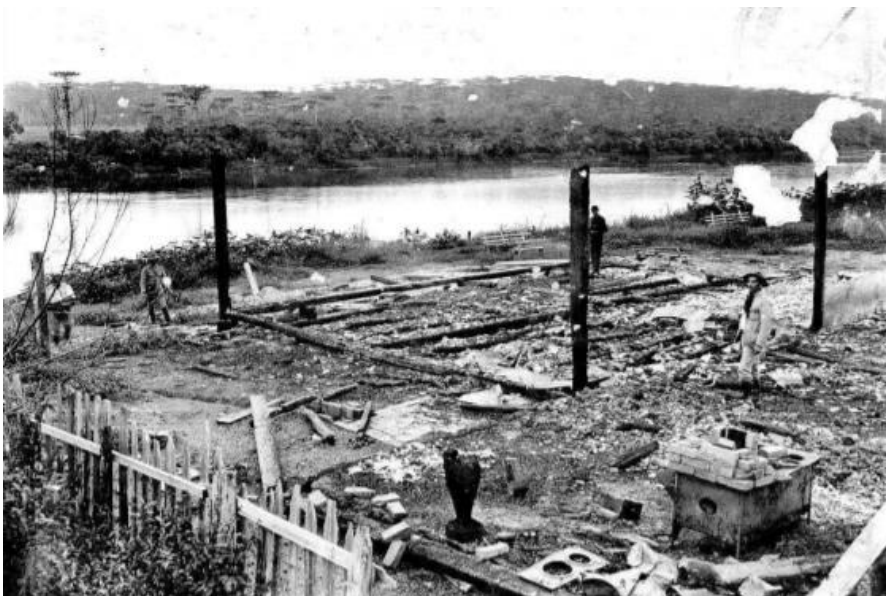
Figura 1 - Escombros da Fazenda Santa Leocádia
